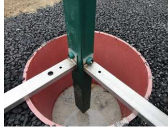
Einbau in Köcherfundament
